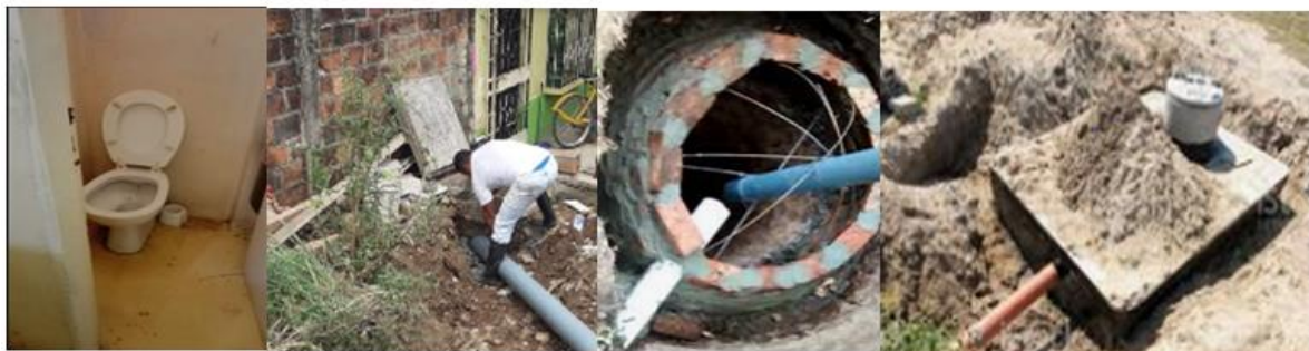
Excusado conectado a pozo ciego
